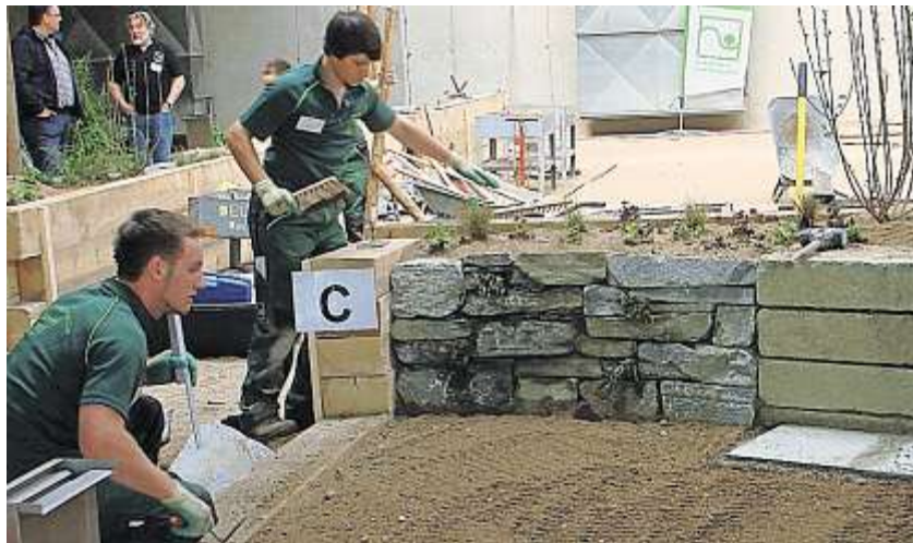
Simon Günthner (l.) und Markus Rappl mit ihrem fast fertigen Bauwerk
